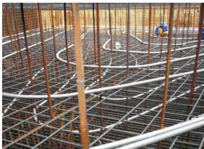
採用核心筒大體積混凝土裂縫控制技術進行水資源循環利用
